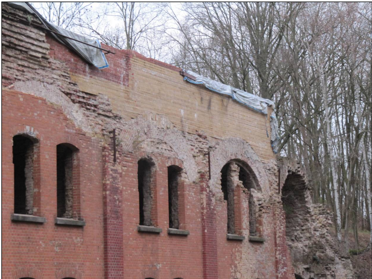
Abb. 17 Rechte Kehlkasern des Fort Hahnebergs
