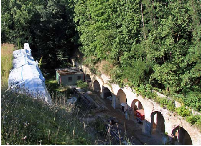
Blick in den rechten Kehlgraben mit angrenzendem Robinien-Pionierwald.
