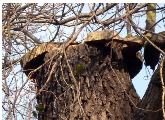
Abbildung 13: Mit Holzscheibe verschlossene Schnittstelle (Dresden).
