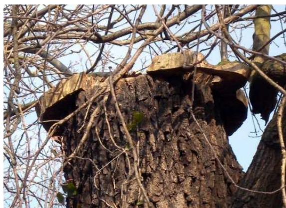
Abbildung 11: Mit Holzscheibe verschlossene Schnittstelle (Dresden).
