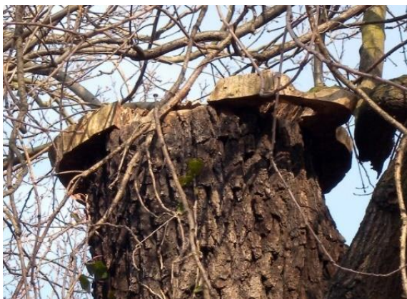
Abbildung 36: Mit Holzplatte verschlossene Schnittstelle (Dresden).
