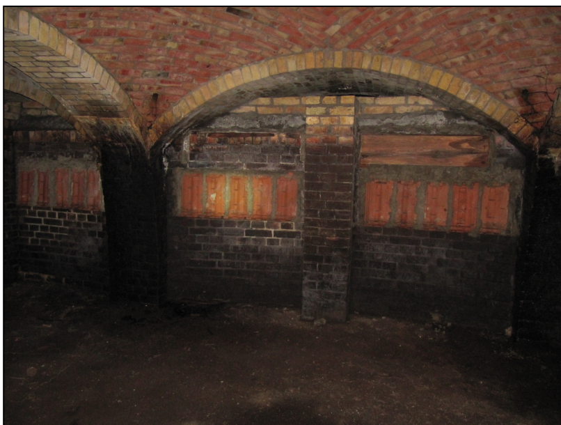
Abb. 17 Innenbereich des Langsandsandfilters Ost im WW Tegel (hier: Dachsteine als Spaltenquartiere)
