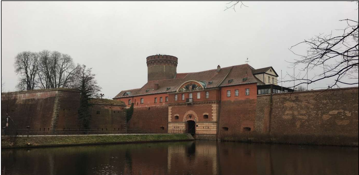
Abb. 32 Ansicht Eingangsbereich Zitadelle Spandau
