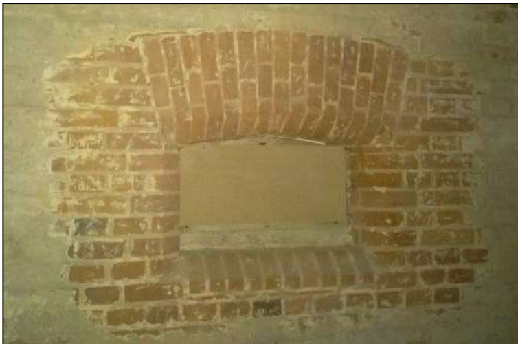
Abb. 28 Fensterverschluss Bastion Königin
