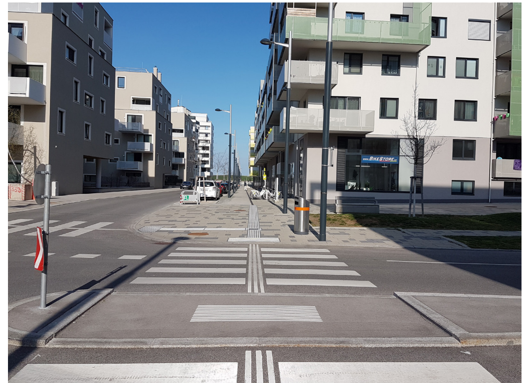
Abb. 38 Beispiel einer barrierefrei ausgestalteten Mittelinsel (Seestadt Aspern, Wien)
